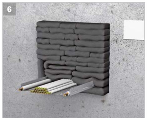
Die Brandschutzkissen sollten nach Möglichkeit stoßversetzt eingebaut werden. Abschließend muss die Abschottung mit einem Kennzeichnungsschild versehen werden.
